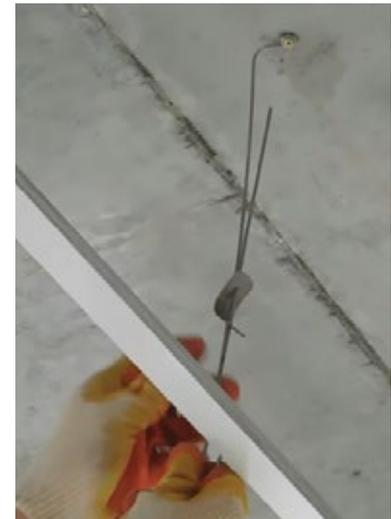
**!** Важно помнить, что подвесы не должны быть ниже угловых профилей 19/24, в противном случае лишняя длина отрезается болгаркой и снимается фаска, чтобы вставить пружину-бабочку. Подвесы крепятся забивными дюбелями. Чтобы направляющие профили было проще крепить, все крюки на подвесах загибаются в одну сторону.
